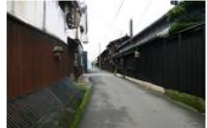
重要伝統的建造物保存地区写真
